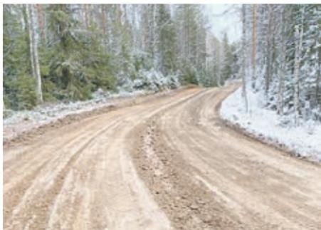
Силами дорожной службы Устьянского леспромхоза отремонтирована объездная грунтовая дорога от д. Бор до д. Шапинской. Работники подразделения произвели пробалку наиболее проблемных участков и отсыпку всей дороги песчано-гравийной смесью. В завершение работ выполнено грейдирование дорожного полотна.
