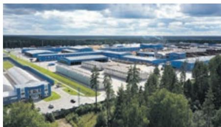
В Устьянском ЛПК введена система обращения с отходами лесопиления. Теперь абсолютно все продукты деревообработки из лесопильных и сортировочных цехов проходят предварительную стадию переработки на рубительной машине до получения топливного сырья нужной фракции. Оно, в свою очередь, сжигается в котельных лесопромышленного комплекса.
